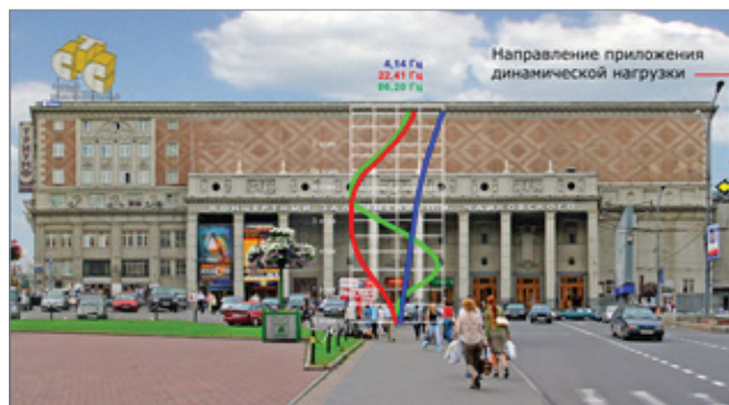
Экспериментальные формы продольных колебаний здания Концертного зала имени П.И. Чайковского на собственных частотах конструкции
