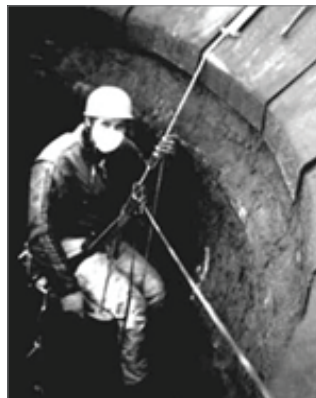
Визуальный метод контроля футеровки проводится на остановленной и охлажденной дымовой трубе
