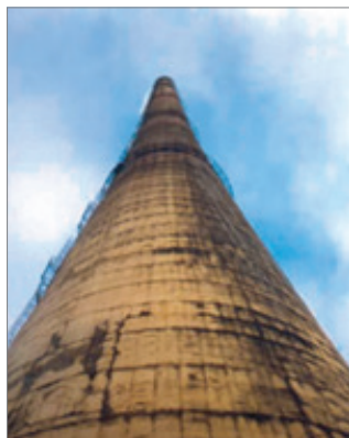
Дымовая труба: ствол железобетонный, футеровка кирпичная, высота 250 м, диаметр 9 м
