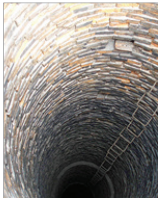
Кирпичная футеровка дымовой трубы
