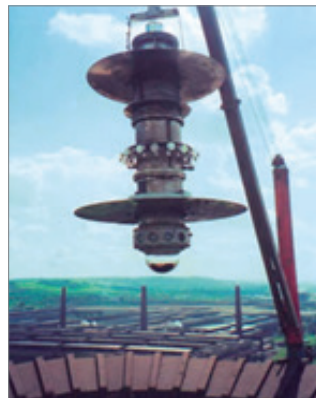
Обследование футеровки функционирующей дымовой трубы с помощью ДК «Сканлайнер»
